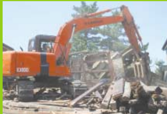
急ピッチで進められる倒壊家屋の解体・撤去作業
